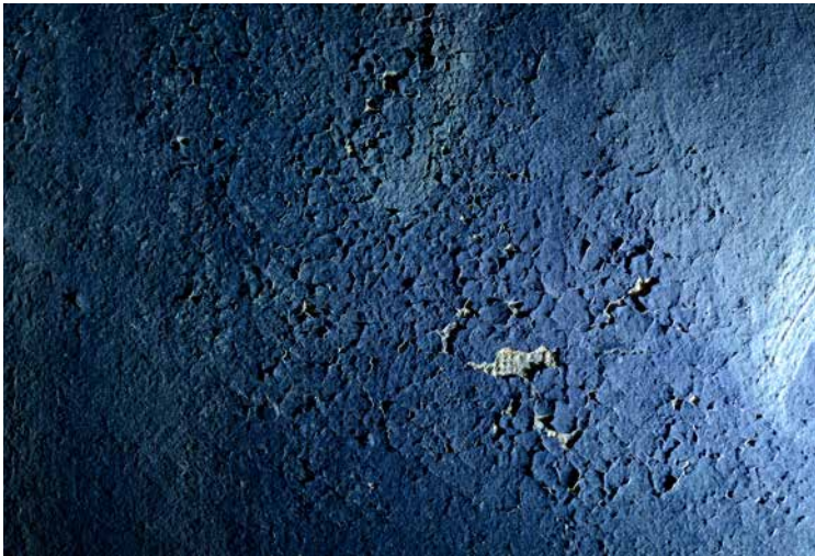
5. Prima del restauro, particolare della superficie pittorica cretata e sollevata
