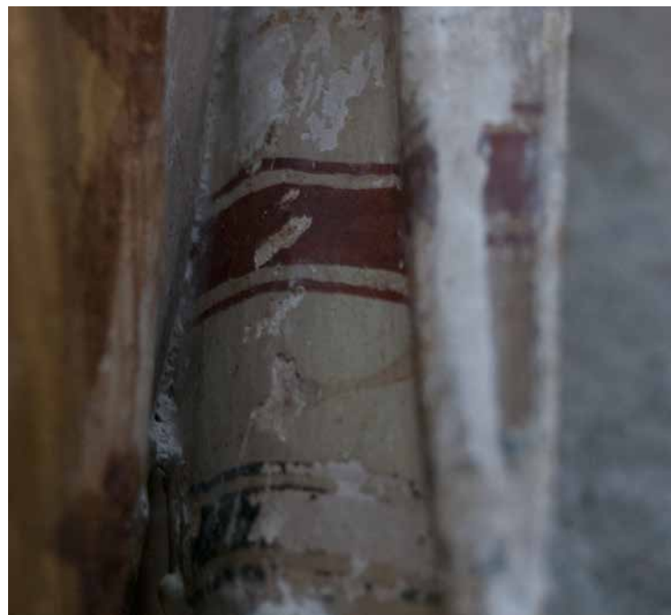
2. Prima del restauro, tracce della decorazione a strisce orizzontali
