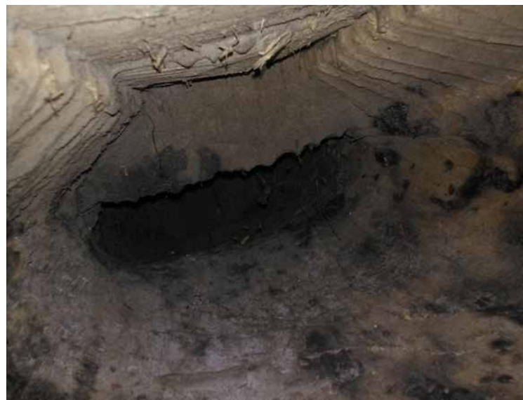
1. Prima del restauro, particolare della modalità esecutiva dello scavo interno
