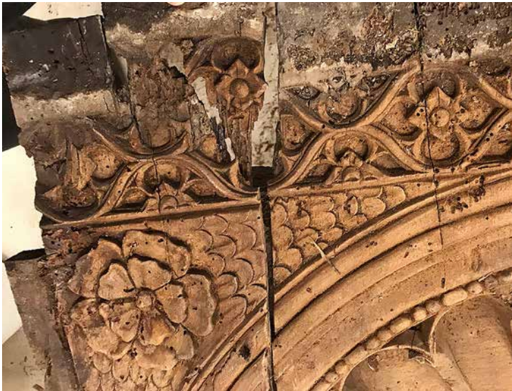
1. Durante il restauro, particolare con lesioni della conchiglia
