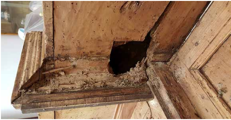
4. Durante il restauro, dopo lo smontaggio, sezione interna del bracciolo destro
