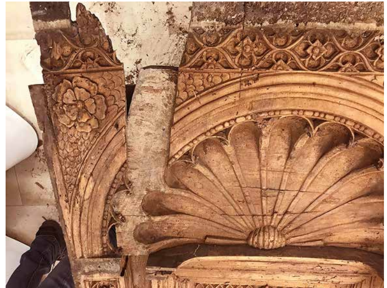
2. Durante il restauro, particolare con un vecchio inserto di risarcimento su una lesione della conchiglia
