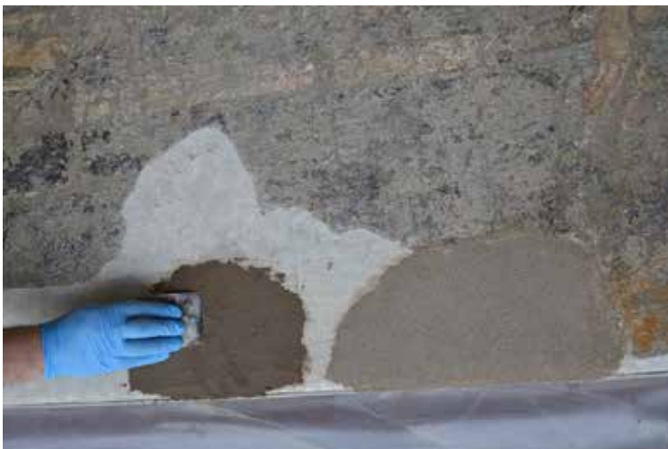
7. Durante il restauro, particolare delle lacune perimetrali, prove di campionatura delle malte realizzate con leganti e inerti di tipo naturale
