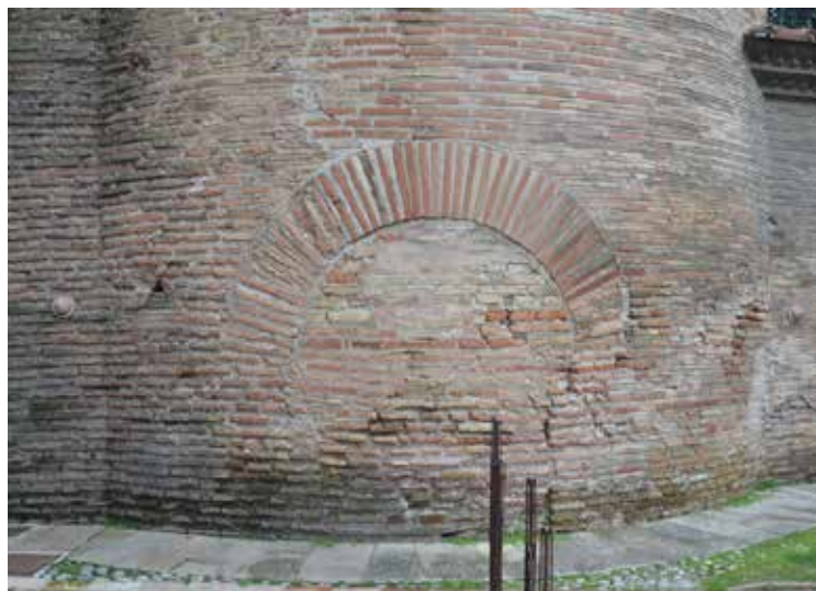
1. Ravenna, Basilica di San Vitale, esterno della cappella del Sancta Sanctorum, particolare del tamponamento dell'apertura esterna ad arco a fungo
