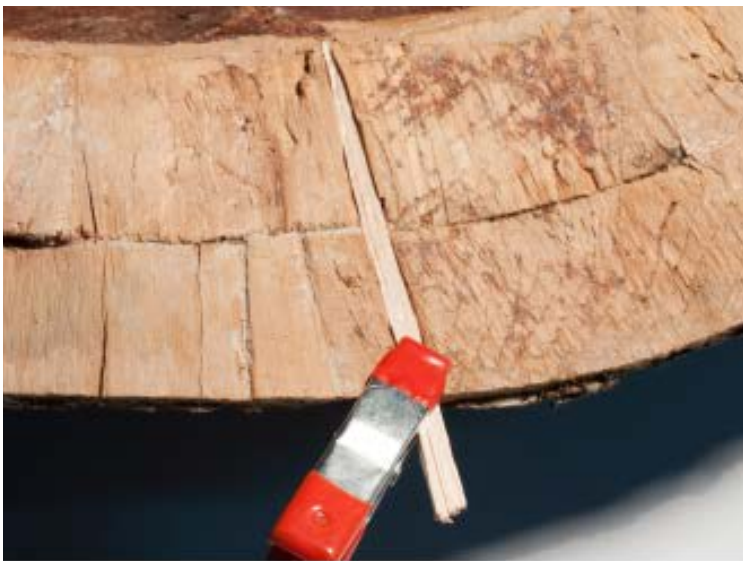
Durante il restauro, operazioni di consolidamento della struttura e di raddrizzamento della tesa
