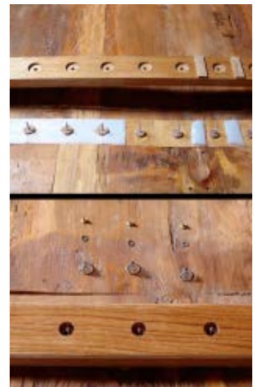
Durante il restauro, retro, particolare del nuovo sistema di traversatura
