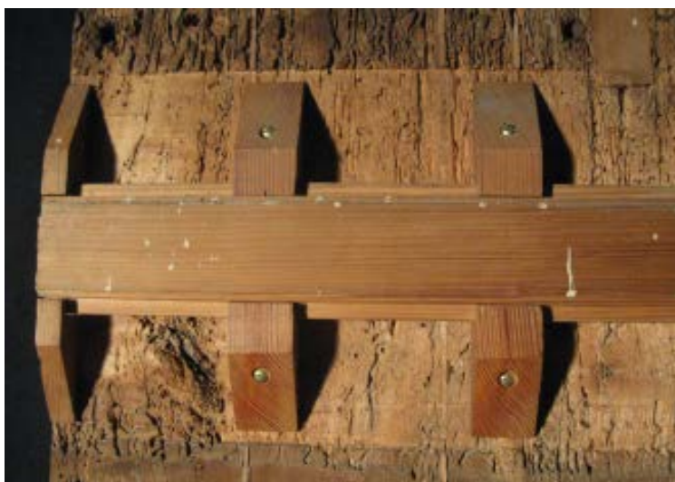
Prima del restauro, particolare della parchettatura
