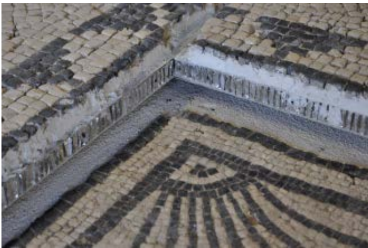
Durante il restauro, particolare dell'inserimento dell'emblema centrale nel tappeto musivo
