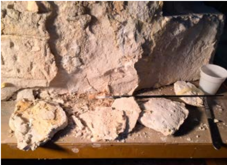
Durante il restauro, distacco di alcuni grandi frammenti alla base della scultura, adesi in precedenza con adesivo vinilico e gesso
