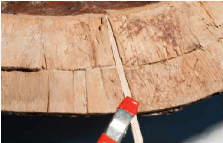
8. Durante il restauro, il consolidamento della struttura lignea
