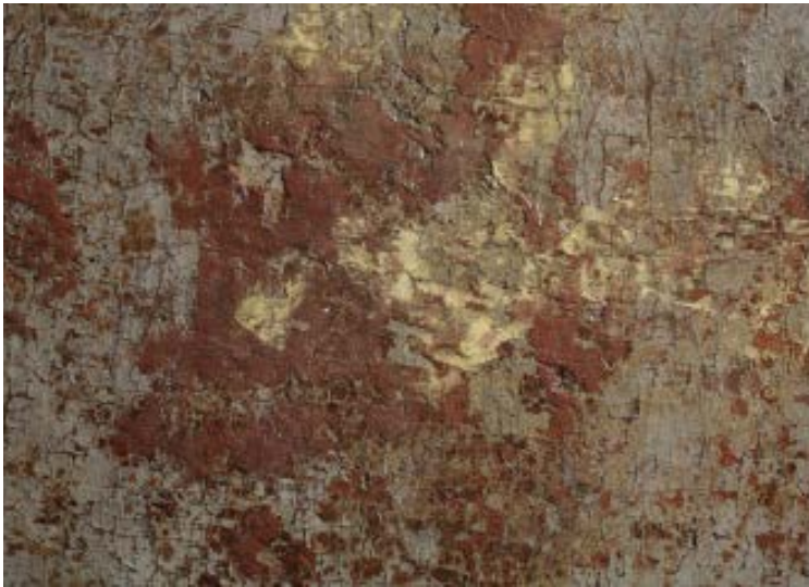
1. Durante il restauro, macrofotografia, stuccature eseguite nei precedenti interventi di restauro
