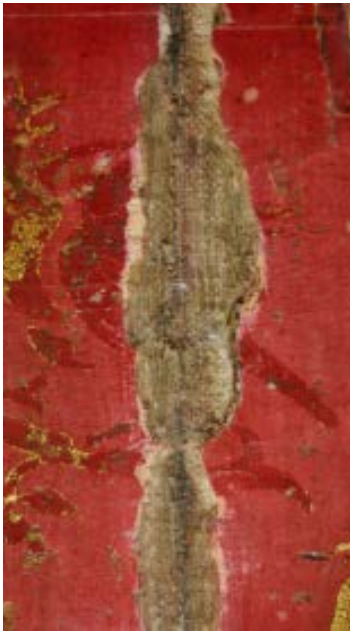
10. Durante il restauro, particolare dopo la rimozione delle stuccature in corrispondenza delle giunzioni delle assi; si osserva la tela di incamottatura
