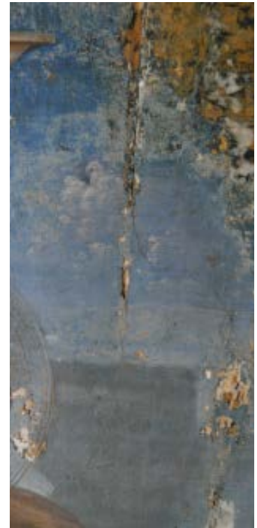
9. Durante il restauro, pulitura, particolare del cielo
