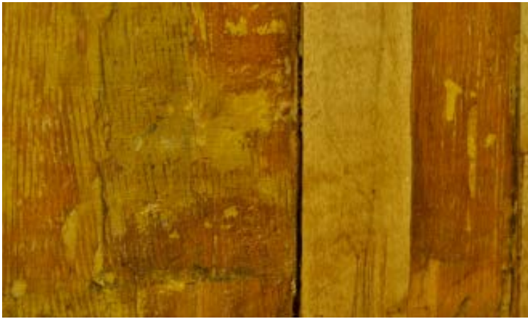
2. Prima del restauro, particolare del supporto ligneo; si osserva un vecchio tassello ligneo separato dalla sede di incollaggio
