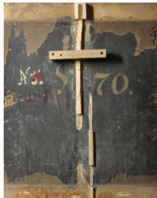
17. Durante il restauro, San Giuda Taddeo percosso e imprigionato, intervento di restauro del supporto ligneo
