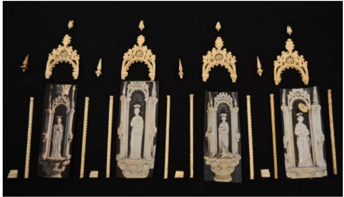
6. Durante il restauro, particolare dello smontaggio delle quattro nicchie degli evangelisti
