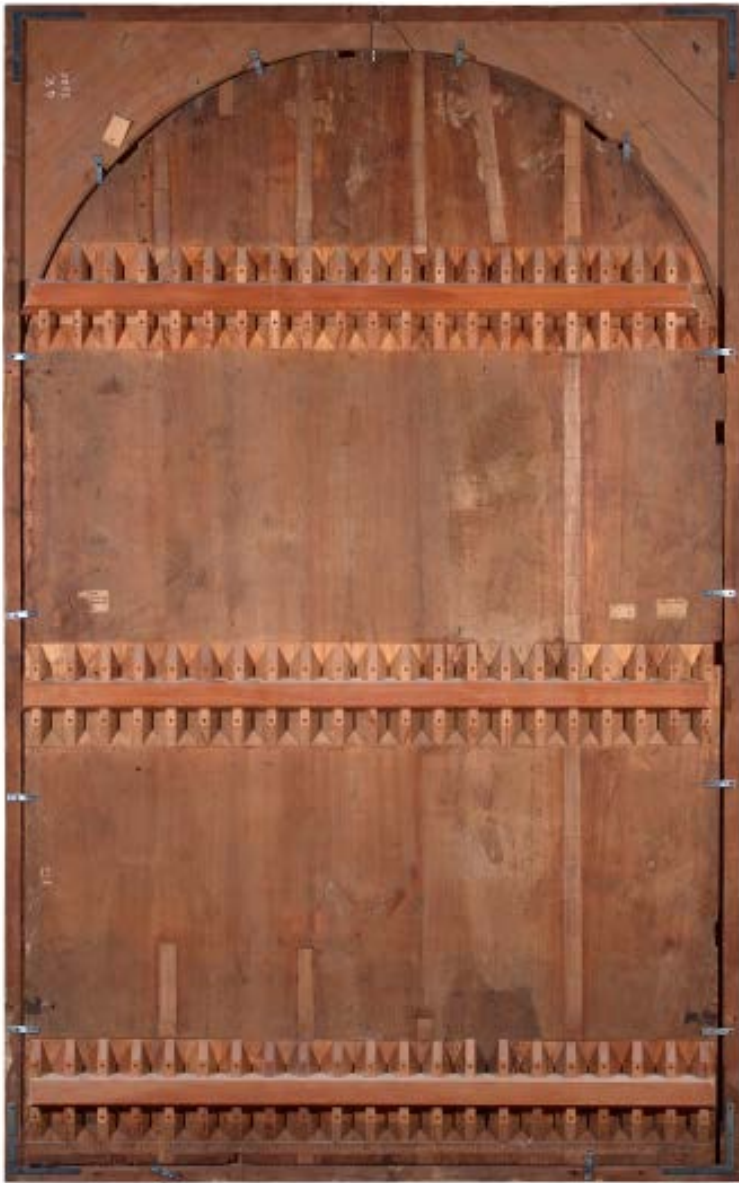
2. Prima del restauro, retro con sistema di traversatura a notte
