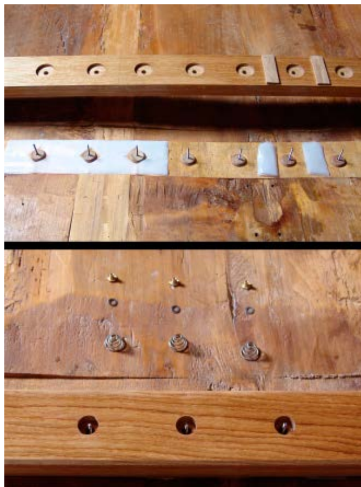
8. Durante il restauro, due dettagli del sistema di traversatura. In alto gli ancoraggi puntiformi basculanti. In basso il meccanismo di ritenzione con molle
