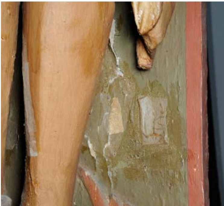
5. Prima del restauro, particolare che evidenzia lo stato di degrado
