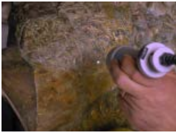
13. Durante il restauro, trattamento di ablazione laser
