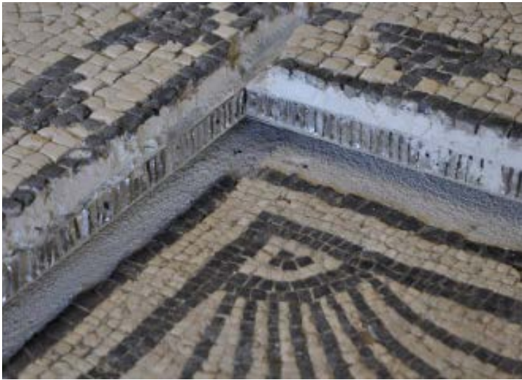
16. Durante il restauro, unione dei pannelli, particolare
