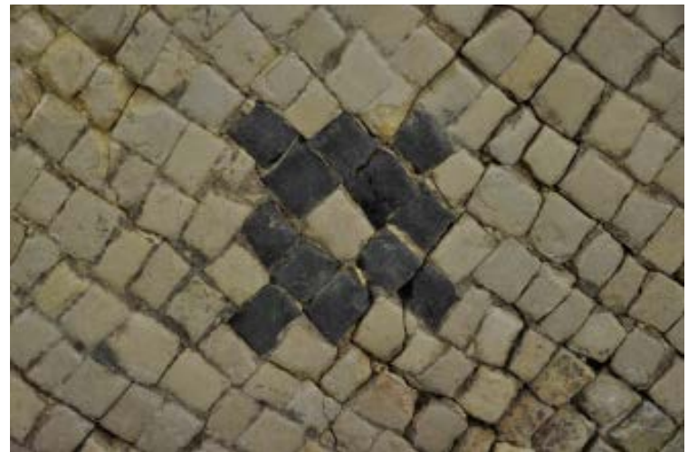
15. Durante il restauro, particolare dopo la pulitura
