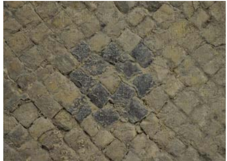
14. Durante il restauro, particolare della pulitura
