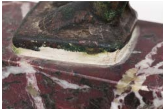
6. Prima del restauro, Arpocrate - Br 328; Osiride - Correr XI, 825. Particolare del perno in ferro (a destra) e della stuccatura a gesso (a sinistra), con cui le statuette erano fissate alle basi di marmo
