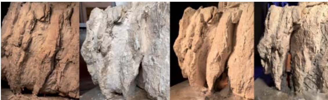
10. a-b) Fasi di rimozione delle stucature superficiali e profonde del restauro di Pietro Franchina; c-d) fasi di risarcimento delle lacune e lesioni del restauro di Cristina del Gallo
